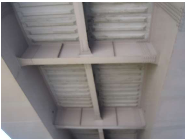
교량 바닥판 전경
