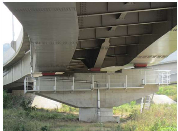
교량 거더 전경
