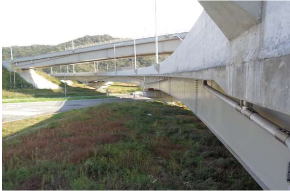
교량 측면 전경
