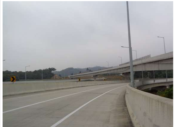
교량 상부 전경
