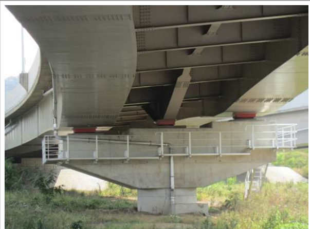
교량 하부 전경
