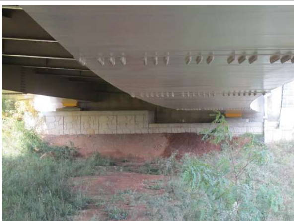
교량 하부 전경
